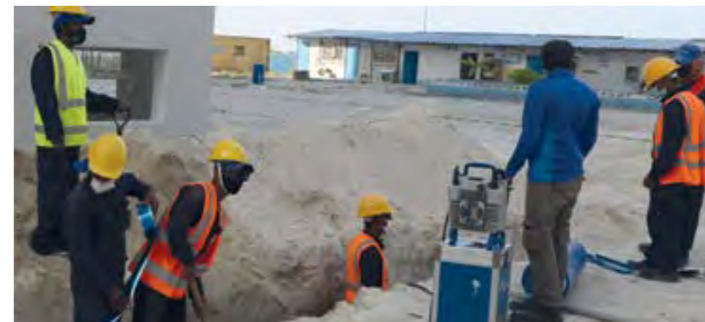
Construcción de red de agua y alcantarillado, Maldivas.
