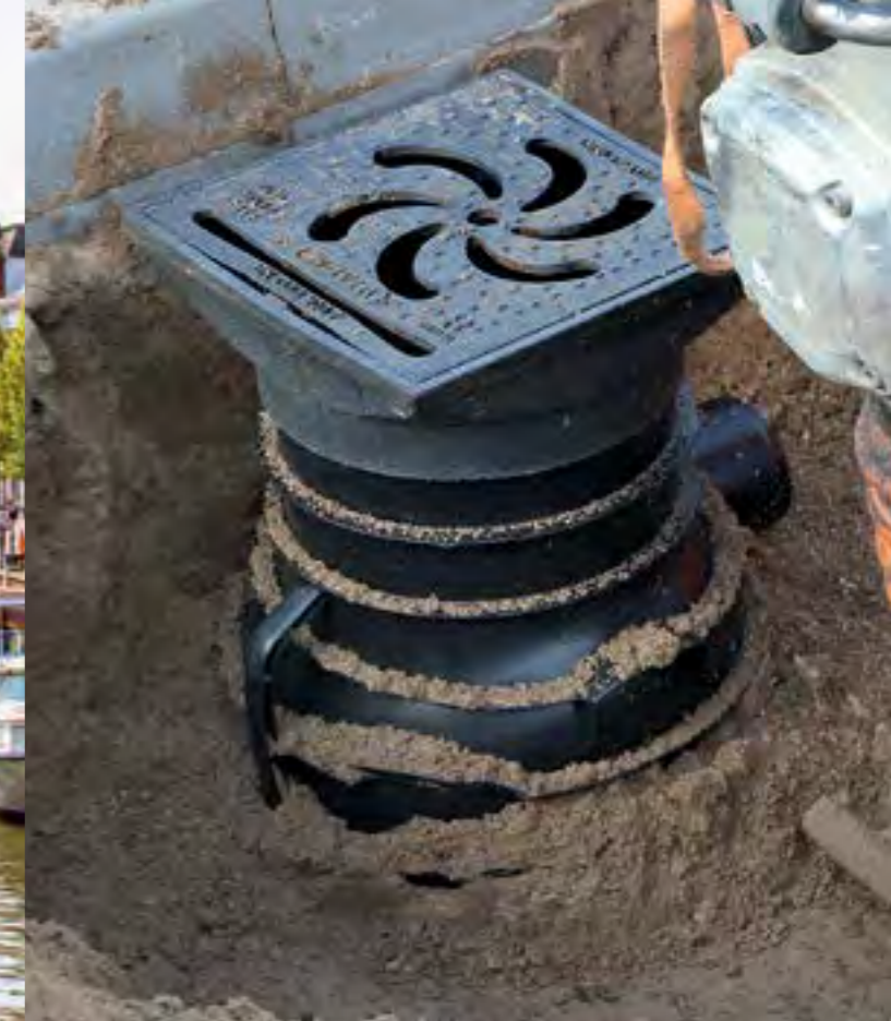
Instalación del sumidero Tegra
